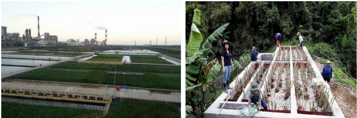
Hình 1.13. Mô hình CW xử lý nước thải tại Công ty Formosa Hà Tĩnh và mỏ Pb-Zn Chợ Đồn, tỉnh Bắc Kạn
