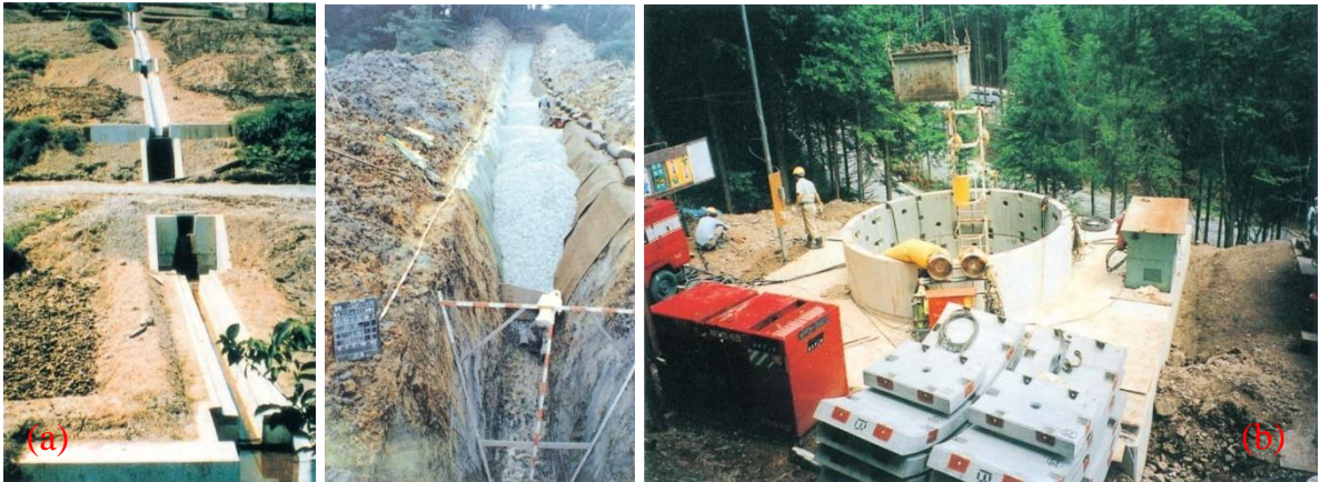
Hình 1. 8. Giải pháp thoát nước bề mặt (a) và sử dụng giếng đứng giảm áp lực nước (b) trên KTL tại Nhật Bản
