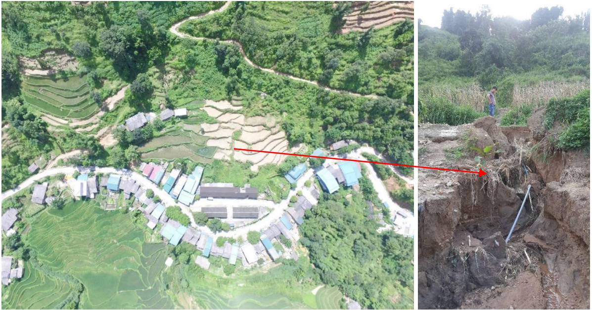
Hình 3.7. Ảnh chụp bằng UAV KTL chợ Tân Sơn, Nám Dẩn và rãnh xói rộng từ 0,5m đến hơn 2m, sâu 1m xuất hiện sau mưa lớn tháng 8 năm 2016
