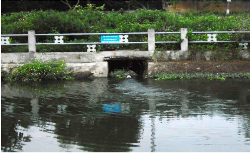
Hình 2: Nước thải xả ra hệ thống sông tại TP. Thái Bình
