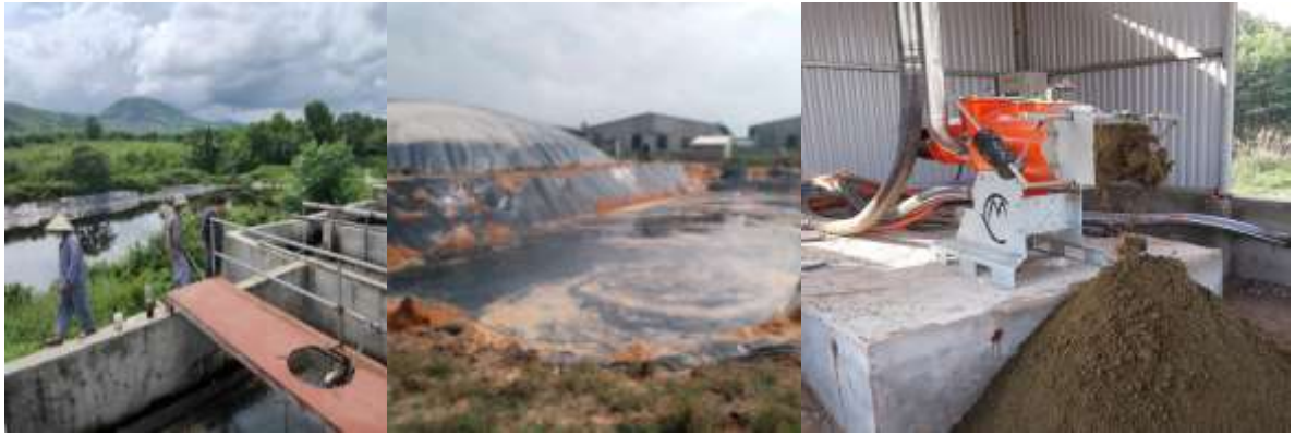
Hình 1.5. Một số hệ thống xử lý nước thải của các trang trại CNL ở Hà Tĩnh (ảnh khảo sát thực tế năm 2018)
