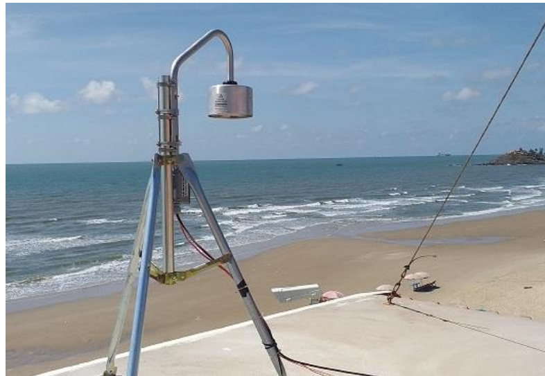
Hình 2.16. Bộ cảm biến của thiết bị EFM-100C, tại Trạm cứu hộ số 1, Thành phố Vũng Tàu
