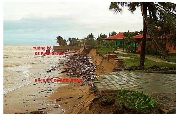
Tường kè KS Palm graden
