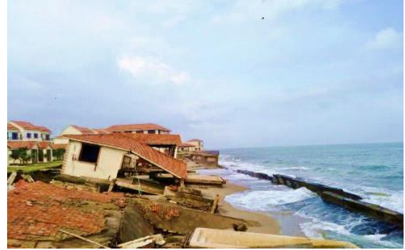
b) Sóng lớn trong bão phá hủy tường kè và cơ sở hạ tầng KS Fusion Alya
