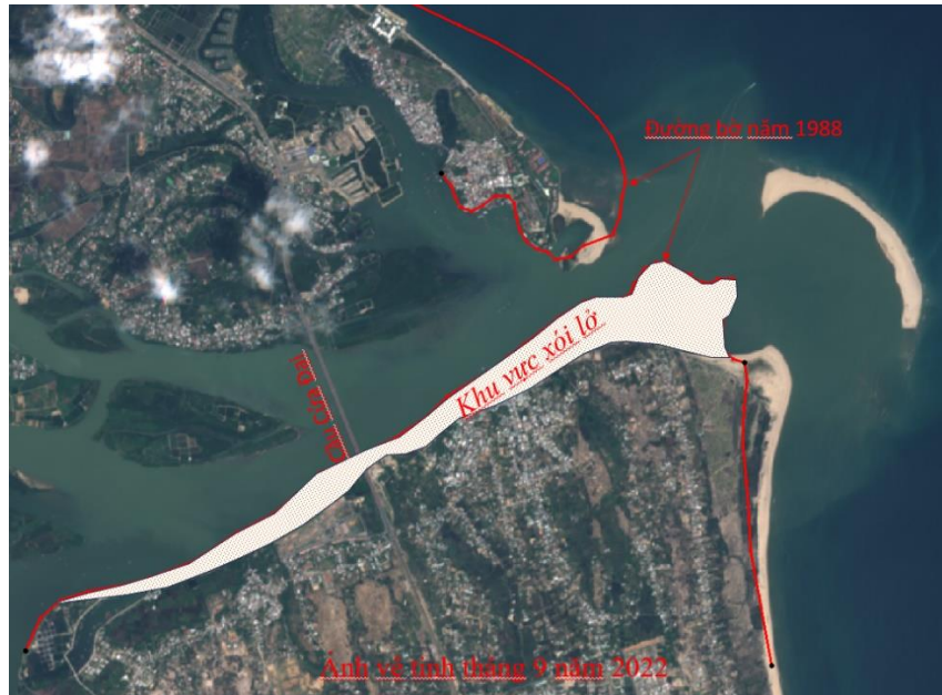
Hình 4.5. Khu vực bờ sông bị xói lở
