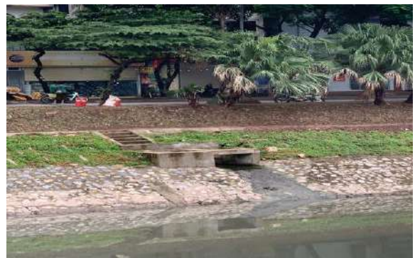
Cửa công thoát nước thải sinh hoạt
