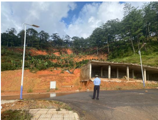
Hình 2.5. Kiểu trượt xoay (Dro), trên mái dốc tại khu đô thị mới Lang Biang, phá huỷ CTXD nhà cấp IV, TT. Lạc Dương: a) Mặt cắt mô tả và b) ảnh chụp hiện trường (2023)
