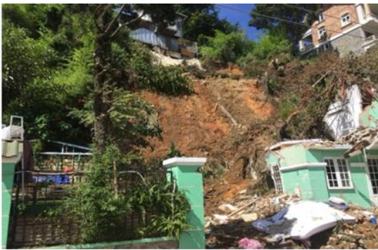
Hình 2.3. Kiểu trượt tịnh tiến (Etr), trên mái dốc tại tại hẻm 27 đường Lê Hồng Phong, phá huỷ CTXD nhà cấp III, TP Đà Lạt: a) Mặt cắt mô tả và b) Ảnh chụp hiện trường (2020)
