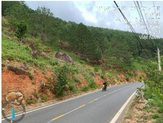
Hình 2.7. Kiểu trượt hỗn hợp (DCo), tại đường tỉnh lộ 725, TP. Đà Lạt: a) Mặt cắt mô tả và b) ảnh chụp hiện trường (2020)
